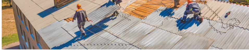
Ход работ по ремонту кровли в Донецке.
