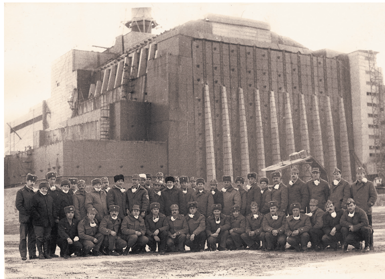
Разрушенный энергоблок к осени 1986 года закрыли бетонным «саркофагом».
